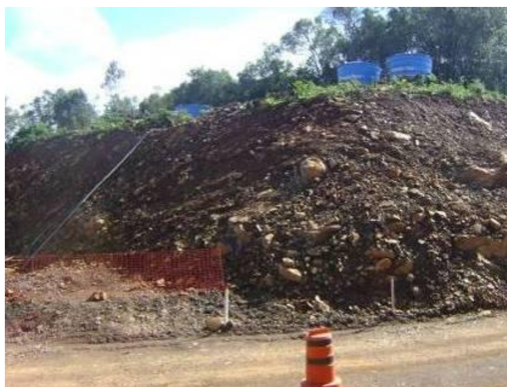
Figura 3: Talude com recomendação de hidrossemeadura
