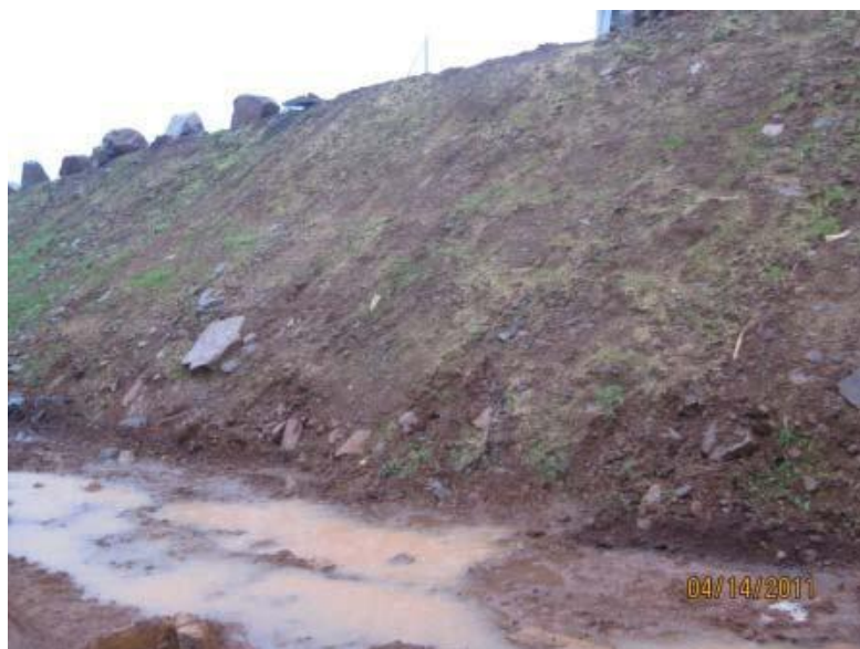
Figura 2: Talude com inclinação média
