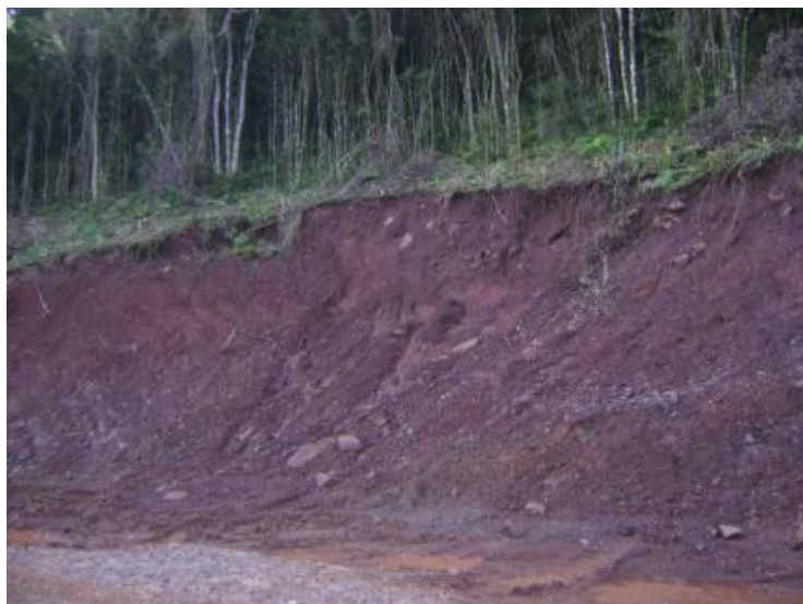
Figura 6: Talude depois da realização do abatimento.
