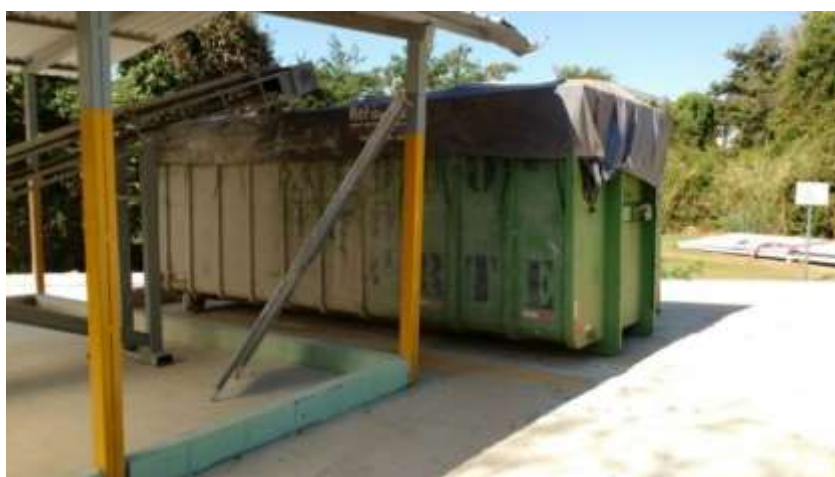
Figura 9. Acondicionamento de Lodo para a destinação final.
