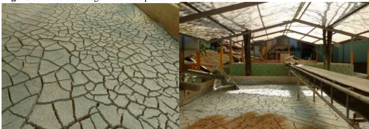
Figura 8. Leitos de Secagem de Lodo proveniente do efluente industrial.
