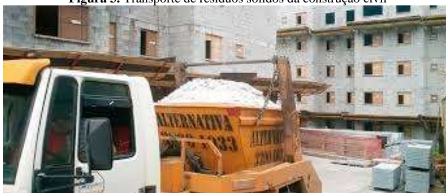
Figura 3. Transporte de resíduos sólidos da construção civil
