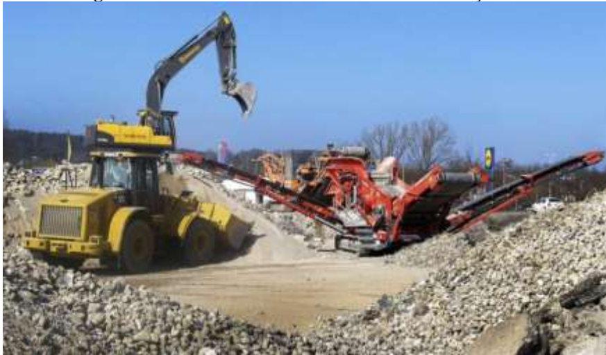
Figura 4. Tratamento dos resíduos sólidos da construção civil
