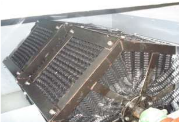
Figura 2– Rotor horizontal do tanque de tratamento biológico
