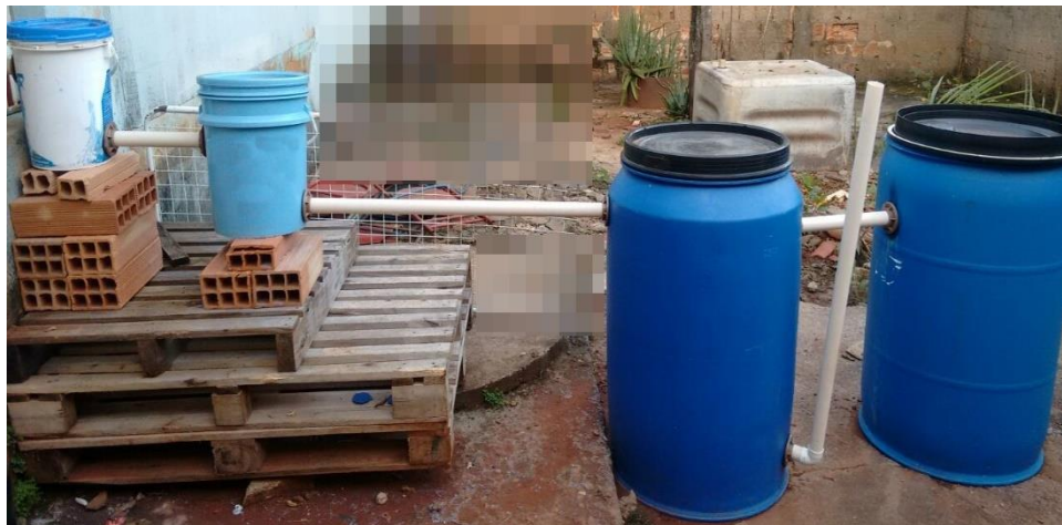
Figura 2. Sistema de tratamento de águas cinza
