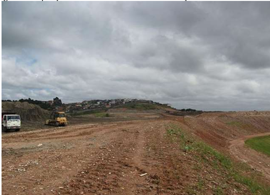
Figura 5. Disposição final de resíduos sólidos da construção civil em aterro de inertes
