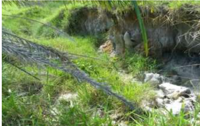
Figura 3 – Voçoroca a montante da nascente.
