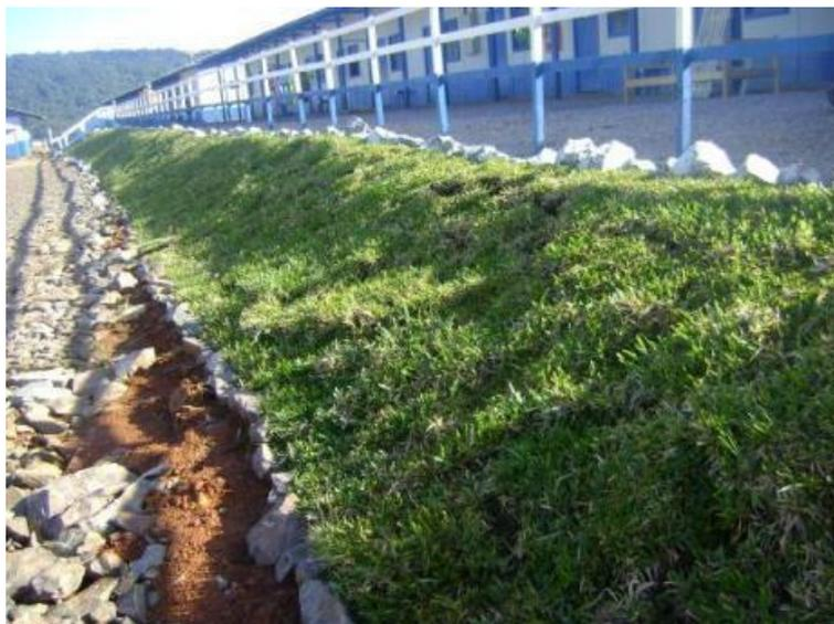
**Figura 4:** Talude com implantação recente de leivas.
