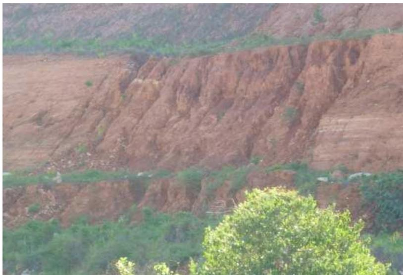
**Figura 1:** Talude com início de voçorocamento.
