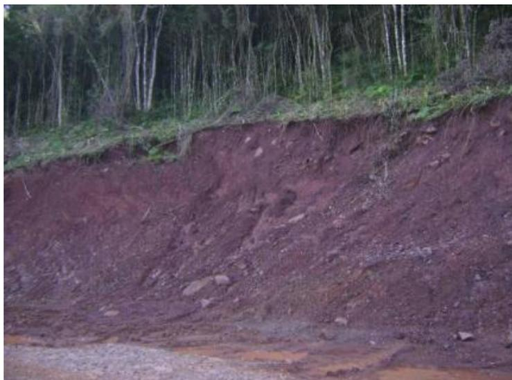
**Figura 6:** Talude depois da realização do abatimento.
