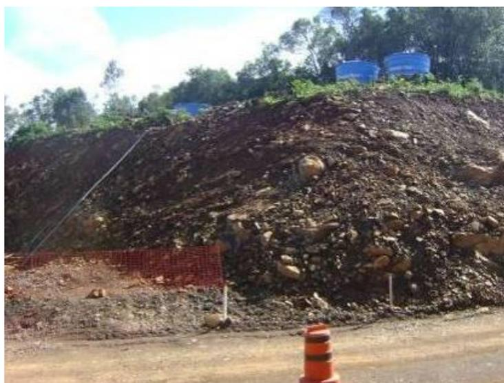
**Figura 3:** Talude com recomendação de hidrossemeadura
